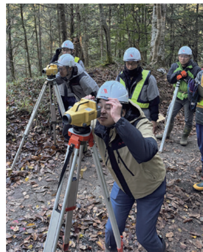
測量作業の様子
