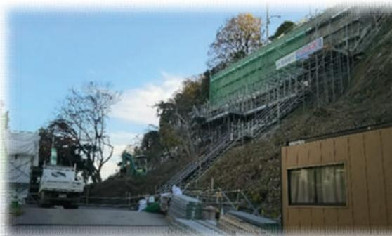
現場事務所内ノートPCと、やぐら内に設置されたTSを無線接続し自動コントロール。あとは24時間365日連続測距・測角したデータを座標化 (X・Y・Z) し、ノートPCがデータを自動管理します。PCへ取り込まれたデータはエクセルデータとして整理し、成果品として納品します。崖の動きや倒れを随時監視出来ます。
